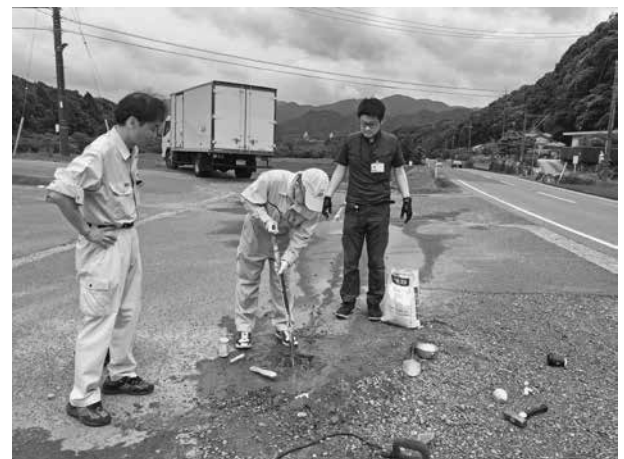
重心点設置作業
