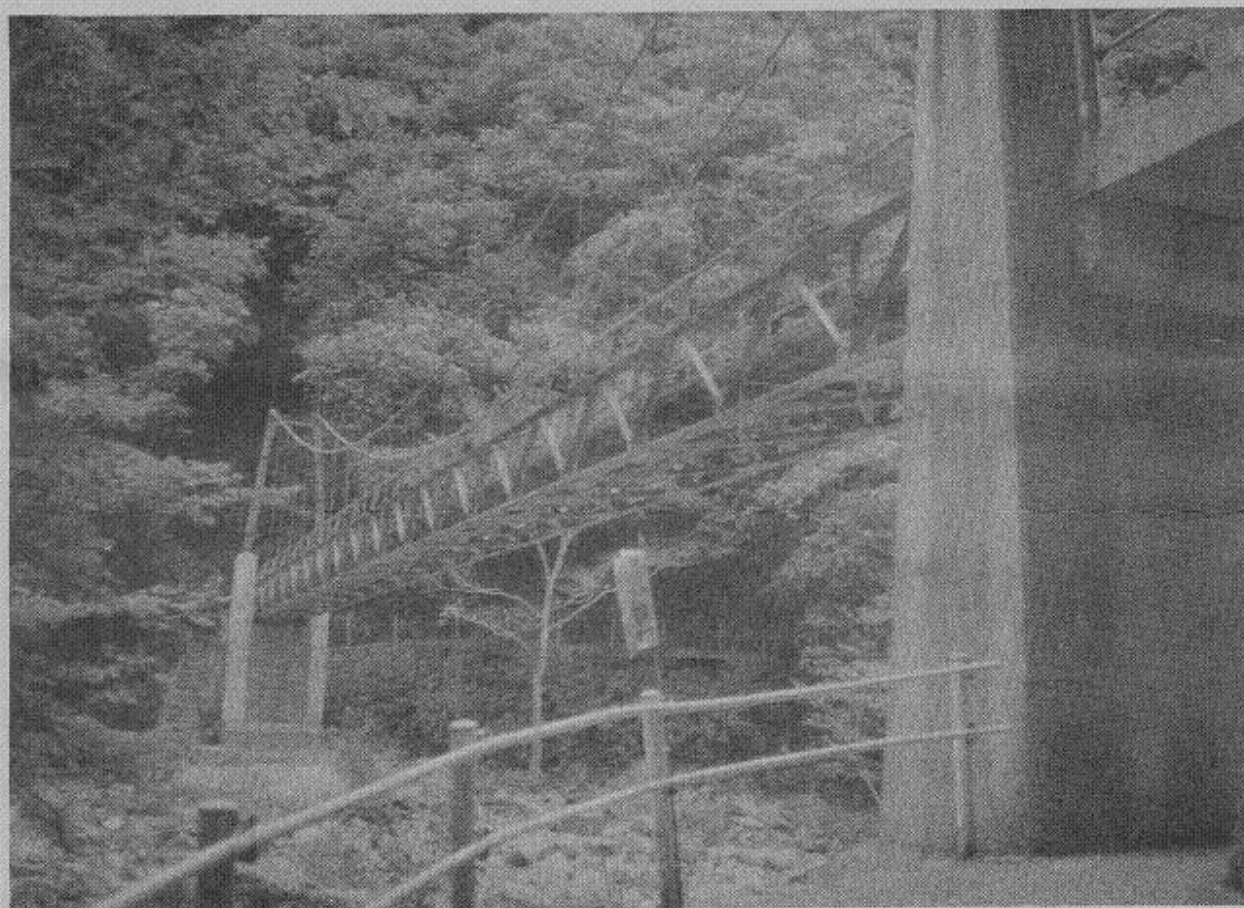
長門峡の吊り橋 撮影 高木義郎会員
